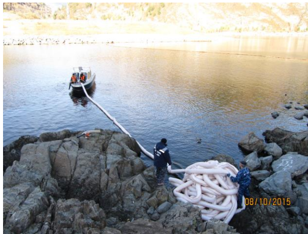
Установка бонового сорбирующего ограждения на водной поверхности с малым течением
