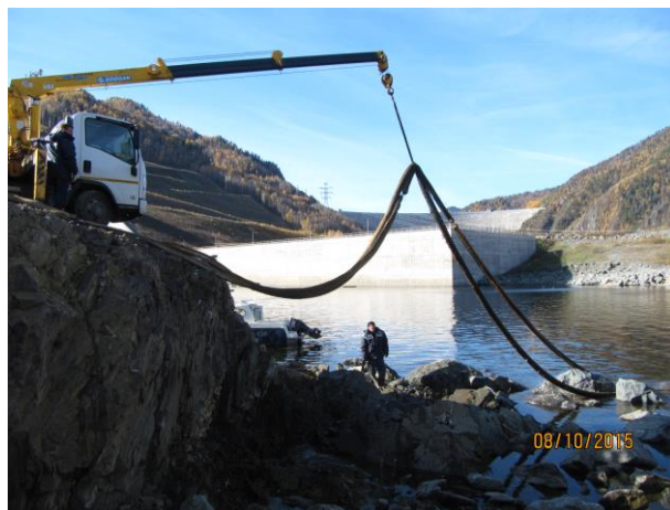
Пример уборки бонового сорбирующего ограждения после полного насыщения нефтепродуктами
